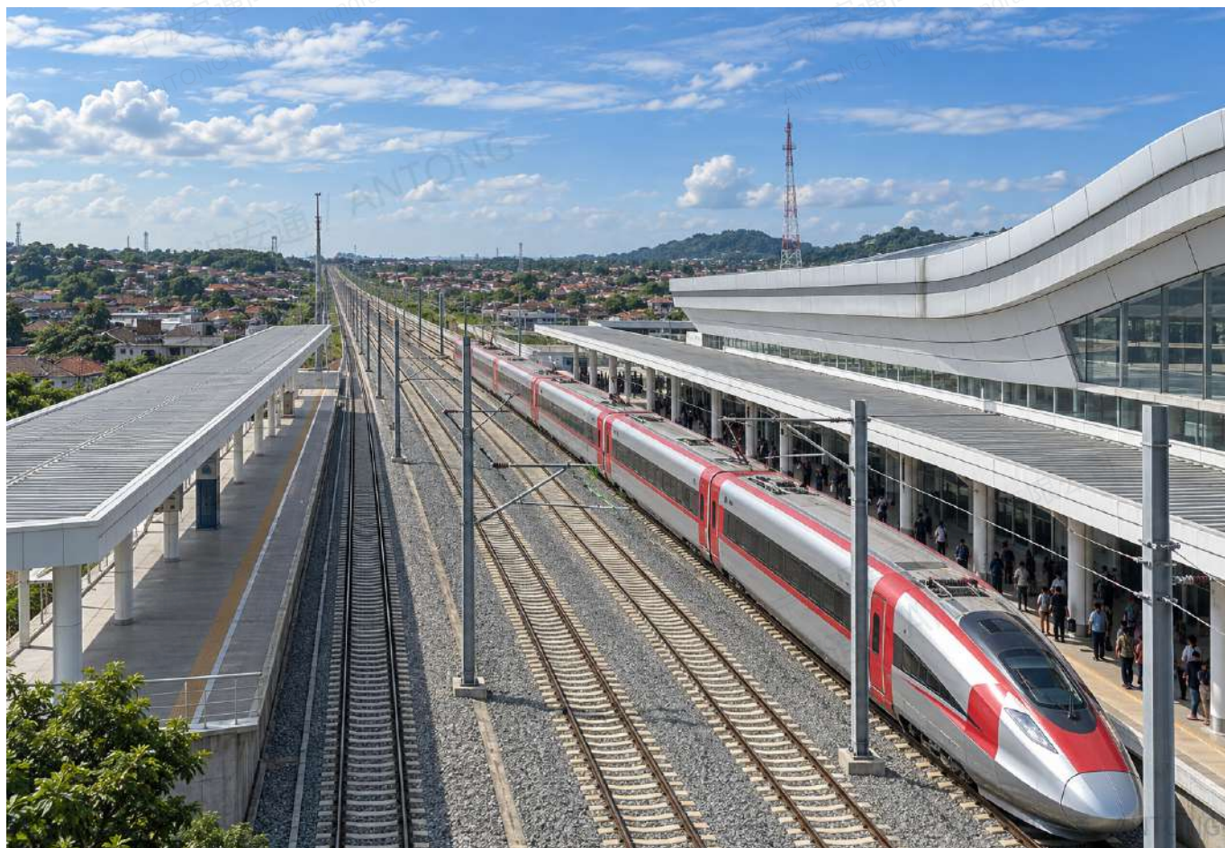
雅万高铁项目实景
