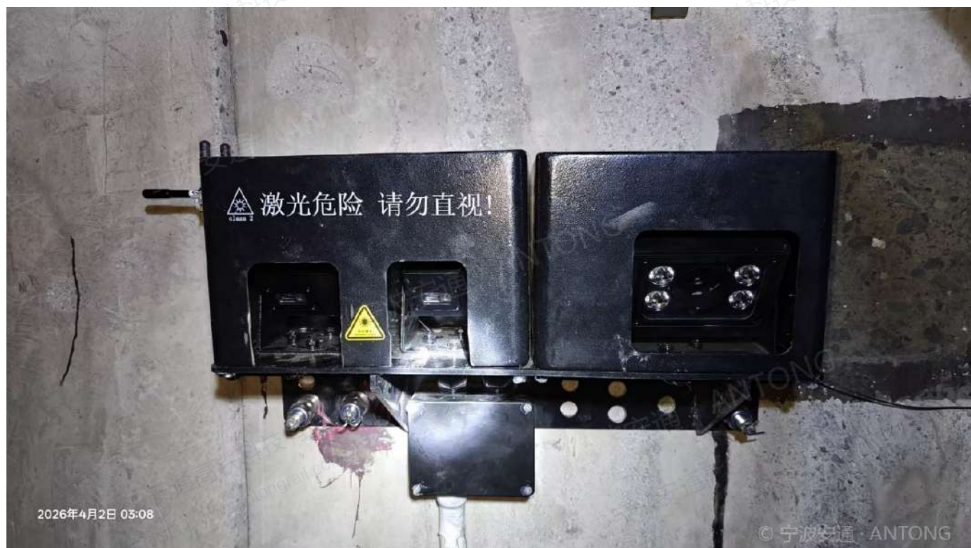
隧道内监测装置安装实景
